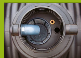
Filtr koszykowy w nadbudowie (wąż z filtrem i bojką – opcja)
